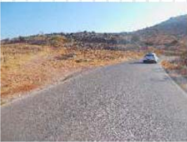
Corte de Carretera
